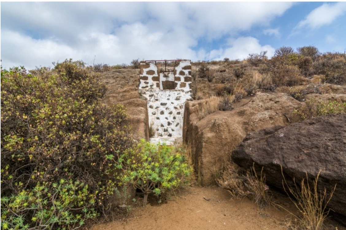
Aljibe y bebedero en Cañada de los Hinojos
